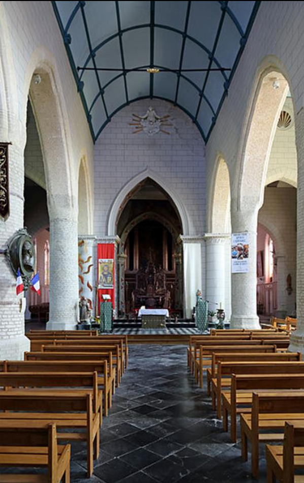
Le vaisseau central : Un arc diaphragme le sépare de la croisée du transept.
